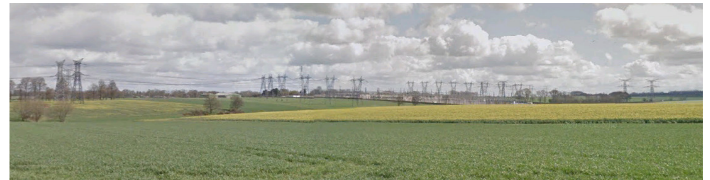
Centrale de redistribution électrique de Bertrimont, près du croisement entre l'A29 et l'A15. Les lignes THT convergent ici depuis les centrales de PALUEL et de PENLY, sur la côte Atlantique. Source : Google StreetView.
